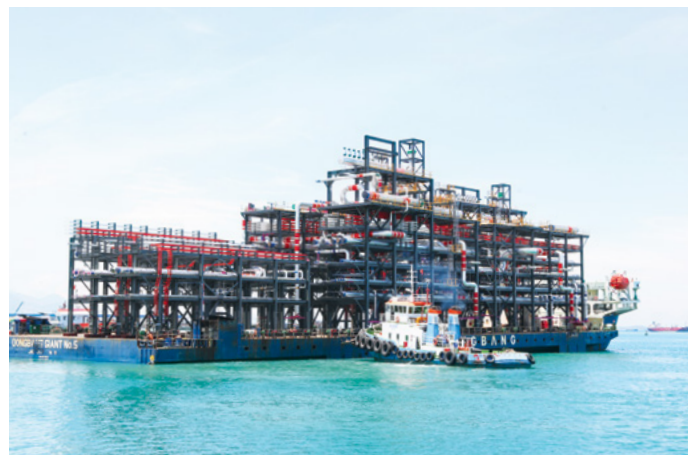
The twelve 1,746-ton modules bound for the Ruwais Refinery, Abu Dhabi // Mười hai module nặng 1.746 tấn xuất khẩu đến Nhà máy Lọc dầu Ruwais, Abu Dhabi
