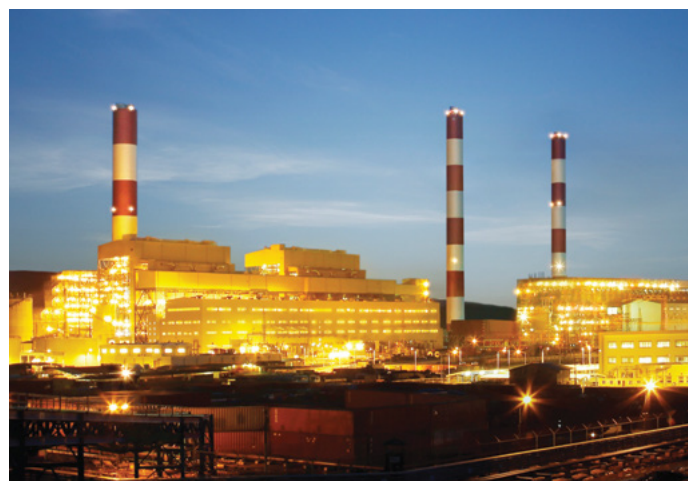
The 1,242 MW Mong Duong 2 power plant in Vietnam by Doosan // Nhà máy nhiệt điện Mông Dương 2 1.242 MW (Việt Nam) do Doosan xây dựng
