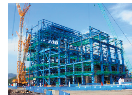
Steel Structures for Mong Duong 2 Power Plant Site, Vietnam // Kết cấu thép cung ứng cho Nhà máy nhiệt điện Mông Dương 2, Việt Nam
