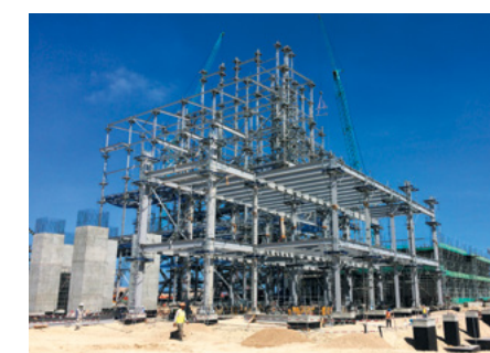
Steel Structures for Vinh Tan 4 Power Plant Site, Vietnam // Kết cấu thép cung ứng cho Nhà máy nhiệt điện Vĩnh Tân 4, Việt Nam
