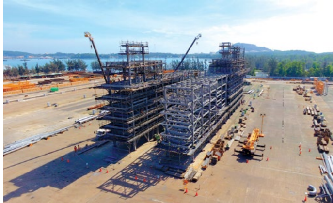
► Erection // Lắp ráp
