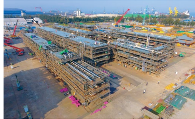
► Erection // Lắp ráp
