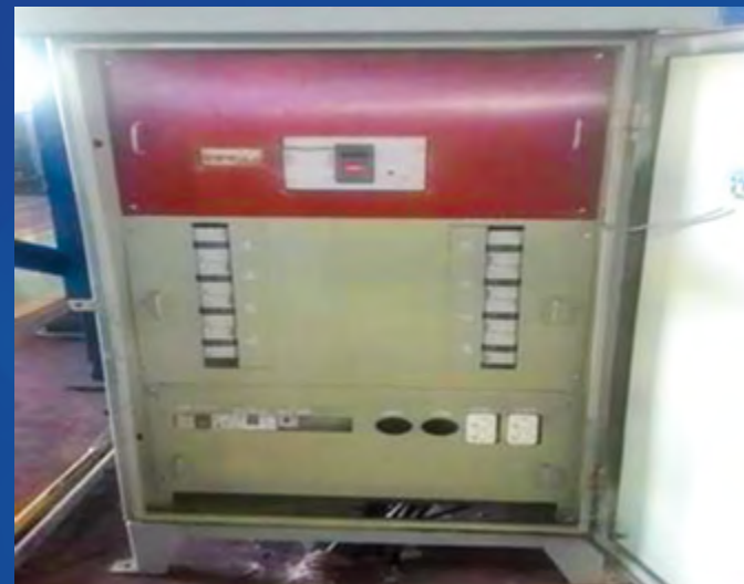
Tủ hàn MD15 400Ampe trước khi và sau khi được nâng cấp lên 1.000Ampe
