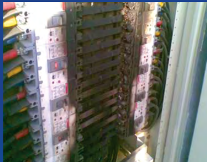
Tủ hàn MD15 400Ampe trước khi và sau khi được nâng cấp lên 1.000Ampe
