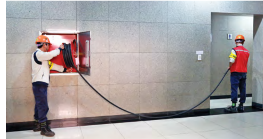
Đội Phòng cháy Chữa cháy Doosan Vina kiểm tra vòi phun nước chữa cháy định kỳ
