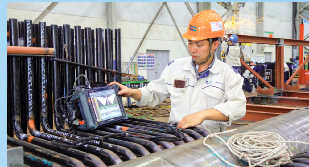
Anh Phạm Quang Lý kiểm tra các mối hàn sử dụng công nghệ Không Phá Hủy tại Nhà máy Boiler
