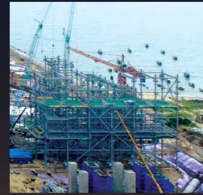
Công trường xây dựng Nhà máy Nhiệt điện Vĩnh Tân 4 Mở rộng
