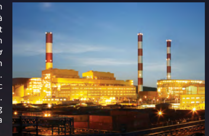
Nhà máy Nhiệt điện Mông Dương II 1,200MW đã được xây dựng và cung cấp thiết bị bởi Doosan và Doosan Vina
