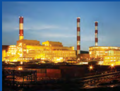
Nhà máy Nhiệt điện AES Mông Dương II, 1.200 MW tại tỉnh Quảng Ninh đã được hoàn thành bởi Doosan Vina
